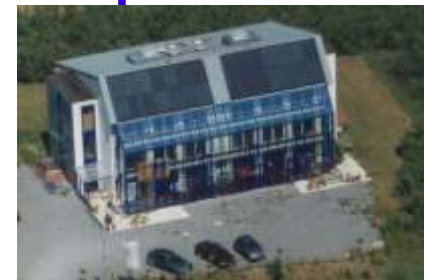
Solarautarkes Gebäude Entwurf und Realisierung STCSolarTransfer
