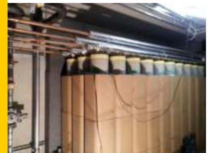
Latentspeicher im Bau
