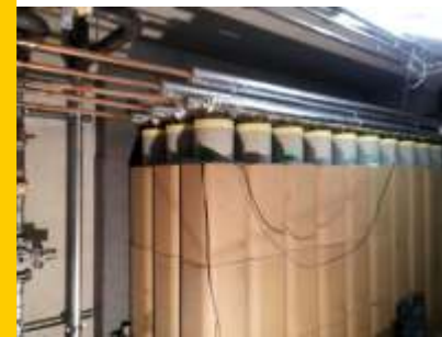
Latentspeicher im Bau
