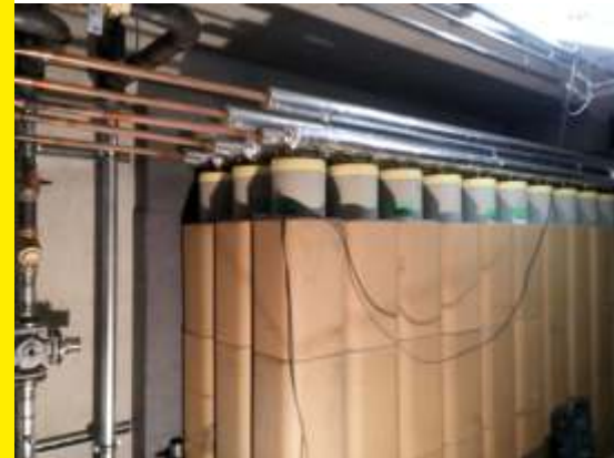
PT-Latentspeicher im „Rohbau“
