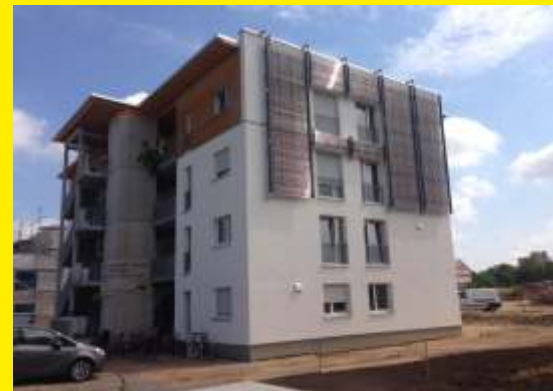
55 m 2 Vakuumröhren-West - Fassade
